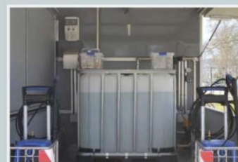
Vista de l'estació de desinfecció
