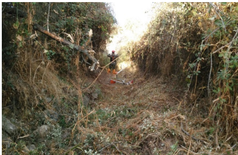
Figura 10: Cauce del arroyo del Peral una vez que se ha limpiado
