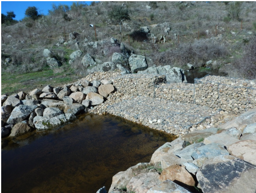
Figura 8: Azud de gaviones construido aguas abajo
