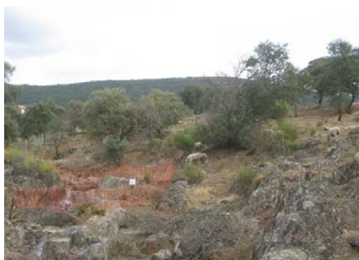
Figuras 22: Malla de señalización de obra para evitar el paso de ganado.
