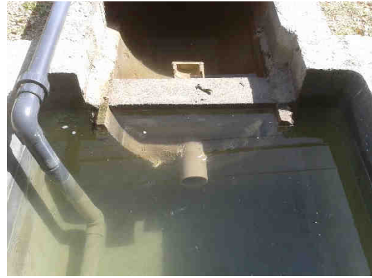
Canal de distribución de agua con capacidad de decantación del agua.
