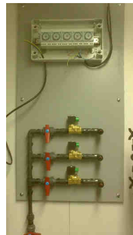
Sistema de control de riego y distribución de agua a los acuarios y cilindroconicos
