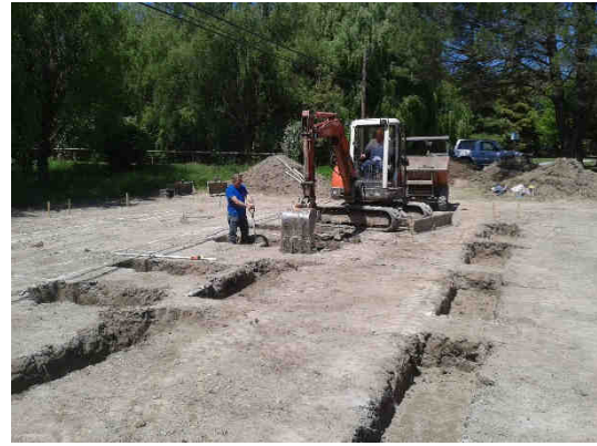
Construcción canales en batería
