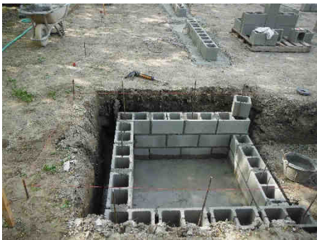
Construcción canales en batería
