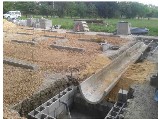
Construcción canales en batería
